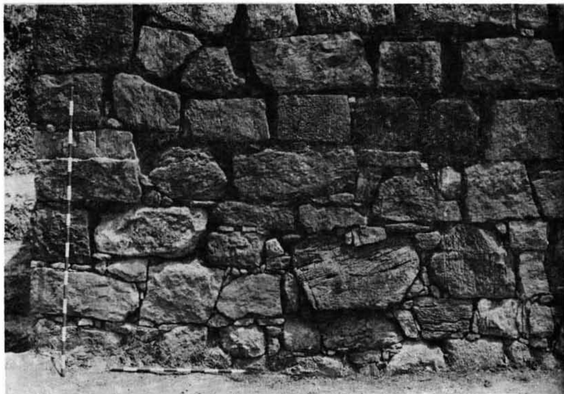
a) Vista general de la zona excavada, desde el este. b) Detalle del muro del segundo lienzo de muralla.
