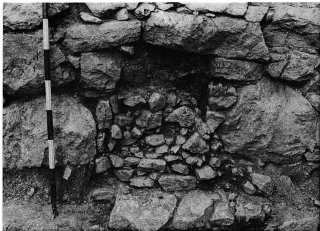
a) El Sondeo D-E, visto desde el este.
