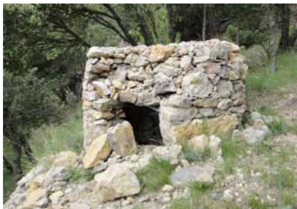
Lám. XIII. Horno para la obtención del aceite de enebro en el mas del Peraire, la Sénia, Tarragona (foto J. Ramos).
