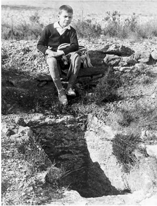
Lám. VII. Pozo de ventilación del acueducto-canal de La Covatella en L'Elia. 1920-1930. (Zalbidea)
