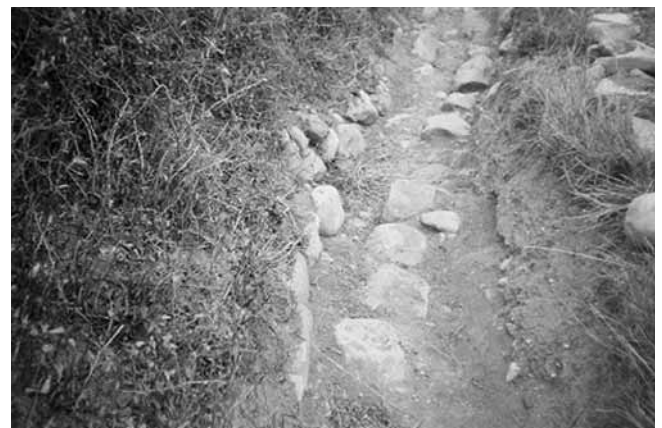
Lám. XXXII. Detalle de la fotografía anterior.
