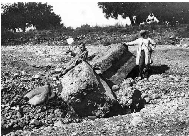
Lám. XIII. Acueducto-canal de Les Llometes a su paso por el Carraixet. 1920-1930. (Zalbidea)
