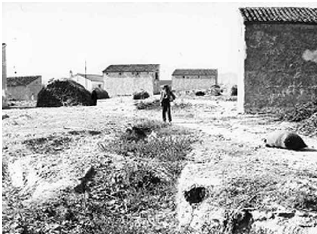
Lám. IV. Acueducto-canal de La Covatella a su paso por las Eras de Benaguasil. 1950. (Zalbidea)
