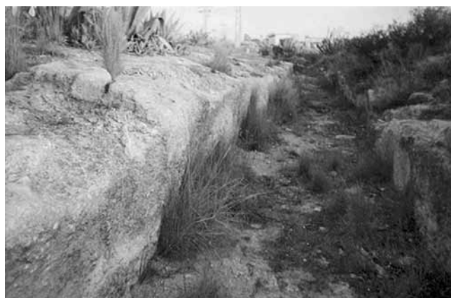
Lám. VI. Acueducto-canal de La Covatella en las proximidades del Centro Comercial de El Osito (L'Eliana).
