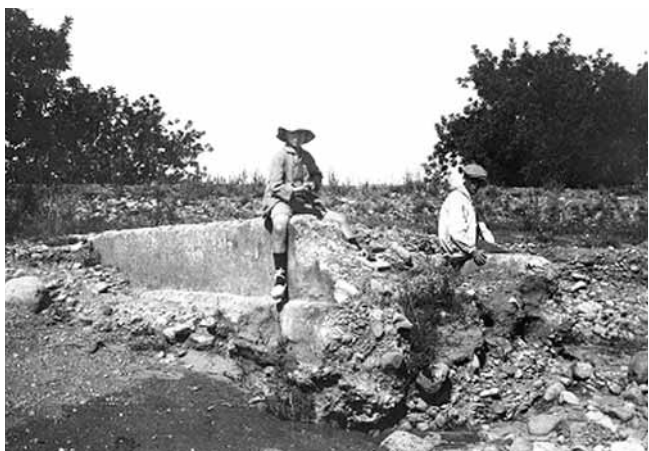
Lám. XII. Acueducto-canal de Les Llometes a su paso por el Carraixet. 1920-1930. (Zalbidea)
